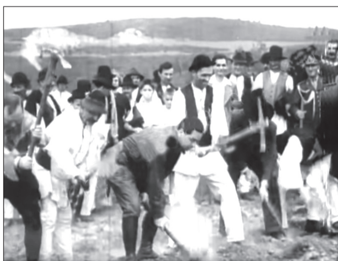
Așa a început construcția Drumului Regelui, cu Primul-Ministru în frunte
