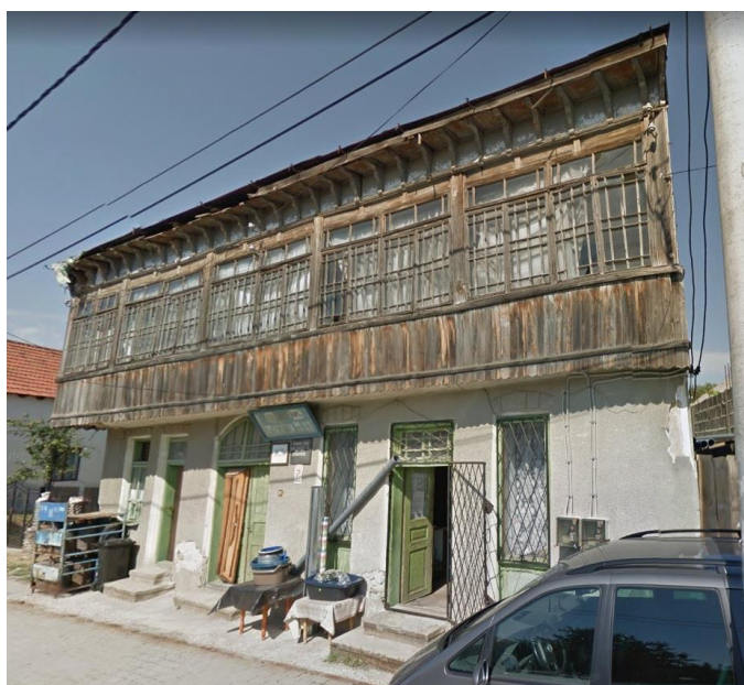
Construcția A3, casă P+M acoperită cu țablă, mansarda este construită din lemn;
