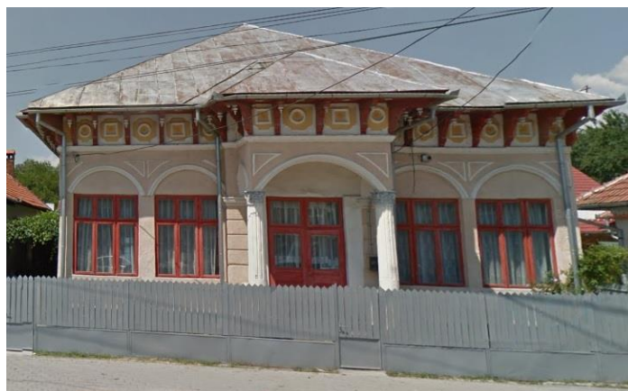
Construcția A2, casă P acoperită cu țablă;
