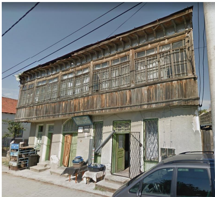
Construcția A4, casă P acoperită cu țablă și țiglă datată 1910;
